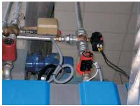
La función fundamental de esta **Solución de Control y Regulación** es mantener constante y estabilizada la temperatura de la masa de aceituna que está siendo batida, dentro de los valores de trabajo preestablecidos, con independencia de los cambios de régimen de caudal de masa al decanter y de las variaciones de presión y temperatura en el circuito de agua caliente de la termobatidora.
